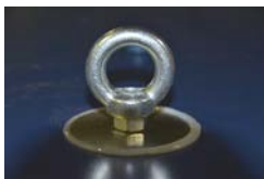
detailfoto: kraanogen op dak van de berging
