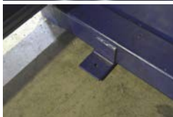
detailfoto: bevestiging aan de vloer
