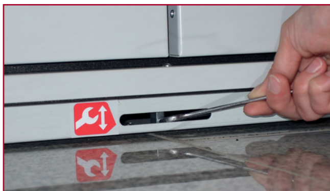
Frontansicht: Unterbauschrank fixiert durch Feststeller
