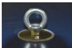
detailfoto: kraanogen op dak van de berging
