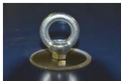
detailfoto: kraanogen op dak van de berging
